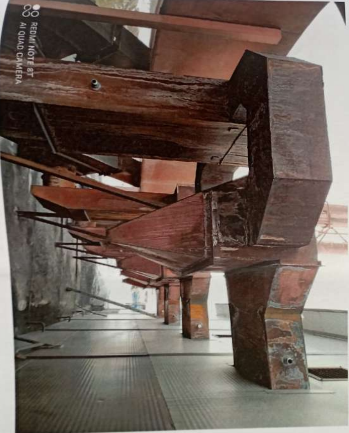
Фото № 5 Пробоотборные отверстия для отбора проб до и после золотуловителей (вид 2)
