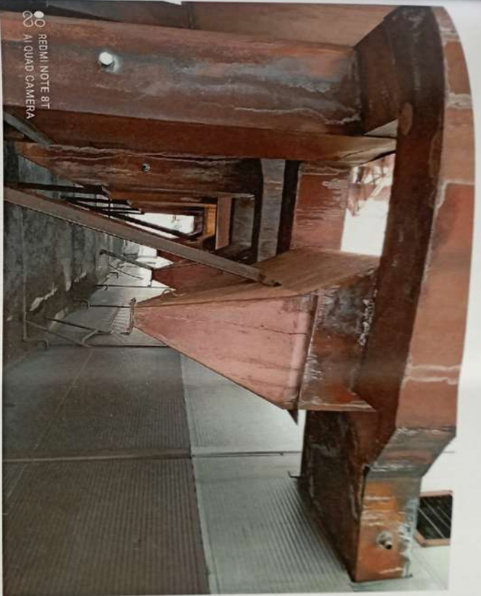
Фото № 4 Пробоотборные отверстия для отбора проб до и после золотуловителей (вид 1)
